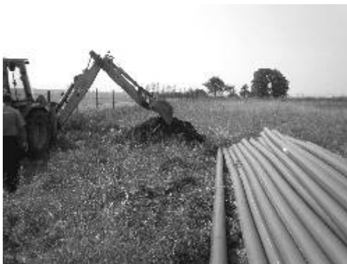
Práce na novém skupinovém vodovodu
