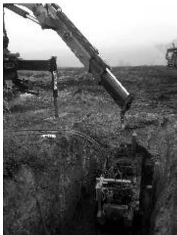
Práce na novém skupinovém vodovodu
