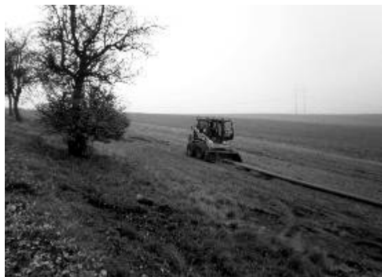
Práce na novém skupinovém vodovodu
